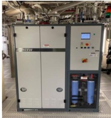
Des systèmes de traitement centralisés redondants qui permettent selon des technologies de lavage avec additifs chimiques ou de combustion de traiter les acides, bases et composés organiques avec **une efficacité supérieure à 90%**.
