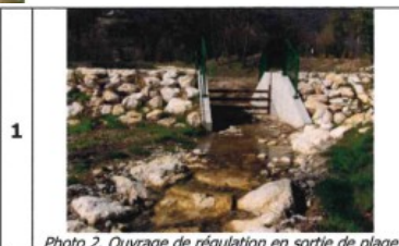
Photo 2. Ouvrage de régulation en sortie de plage
