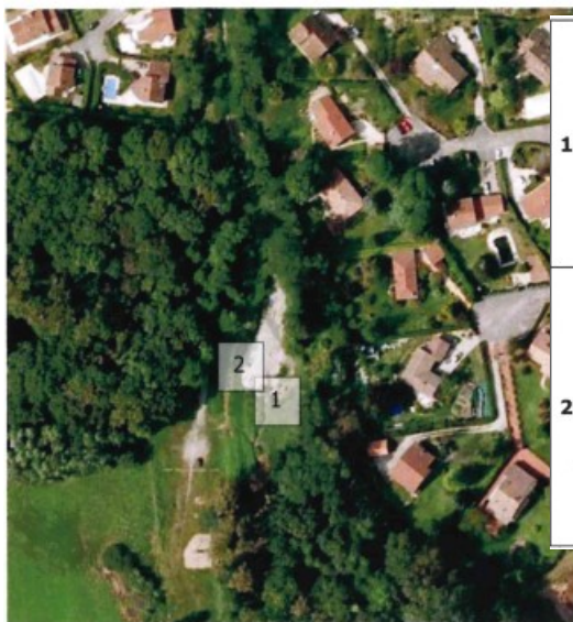
Photo 1. Vue aérienne de l'ouvrage (Google Maps).
